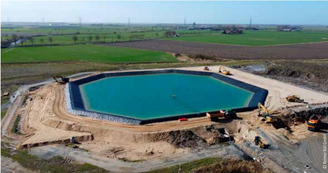
Abbildung 4.19: Saisonalen Erdbeckenspeicher in Meldorf (50.000 m<sup>3</sup>) zur Speicherung der Abwärme aus einer Biogasanlage und einem Industriebetrieb
