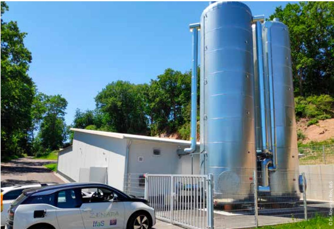
Abbildung 4.16: Wärmespeicher im Bio-Solar-Nahwärmenetz Gimbeiler mit Netzspeicher 50 m<sup>3</sup> (hinten) und Solarthermiespeicher 50 m<sup>3</sup> (vorn)
