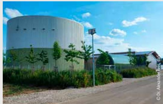
Abbildung 4.17: Großwärmespeicher, Links (5.000 m<sup>3</sup>) und Kurzzeitspeicher, Mitte (200 m<sup>3</sup>) zur Wärmespeicherung in der Energie-Kommune Fuchstal
