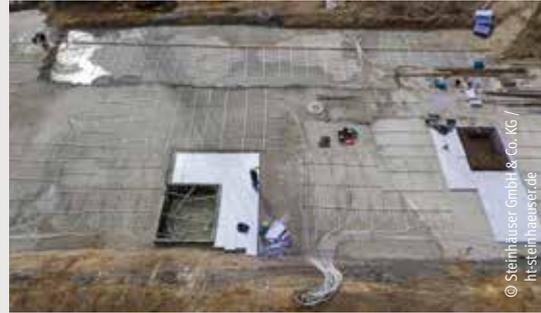
Abbildung 4.24: Erdkollektoren unter Neubauten nutzen oberflächennahe Geothermie
