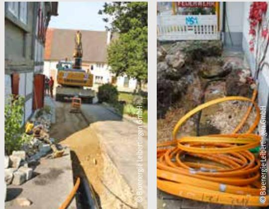
Abbildung 3.7: Verlegung von Glasfaserleitungen
