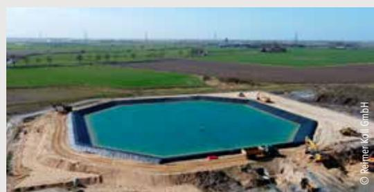
Abbildung 2.5: Erdbecken-Wärmespeicher in der Energie-Kommune Meldorf
